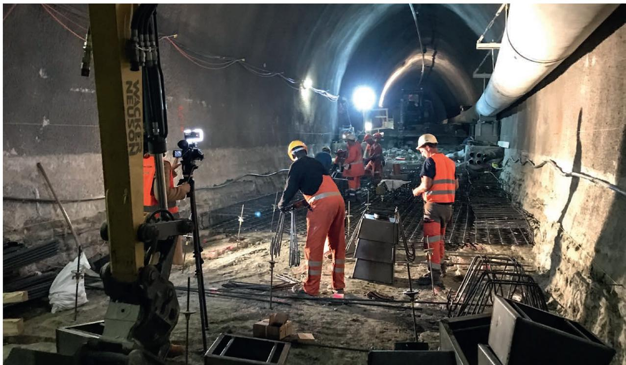
80 cm qui, de plus, sera fixé à l'aide de clous et à une profondeur de 4 à 6 mètres. Ces travaux sont nécessaires pour garantir la durabilité de l'ouvrage. Une information ciblée à l'attention des riverains a été prévue et, au vu des mesures prises par nos planificateurs, les nuisances ont été très faibles.
